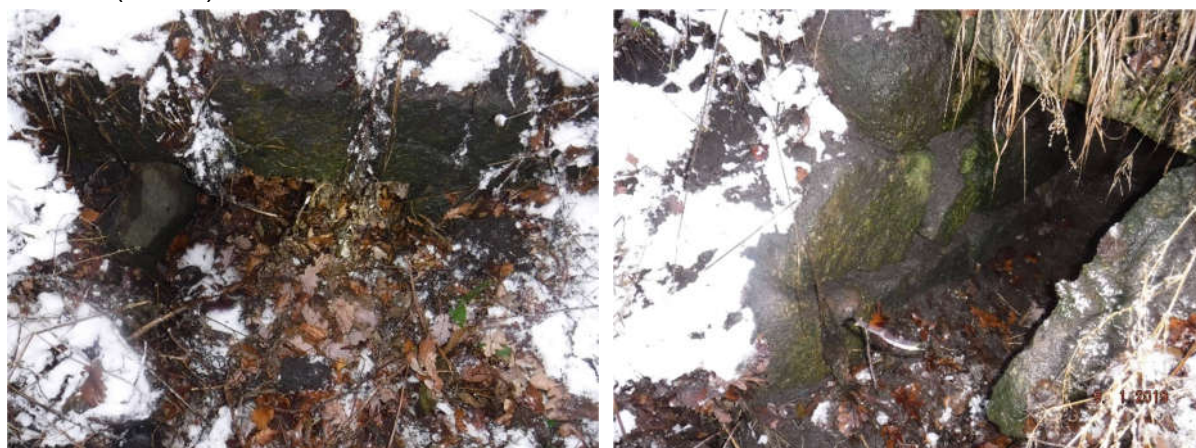
Obr. 6 Stav křídel propustku na vtoku (vlevo) a výtoku (vpravo) – rozvolněné zdivo, vydrolené spárování
