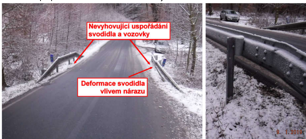
Obr. 12 Závady záchytného systému
