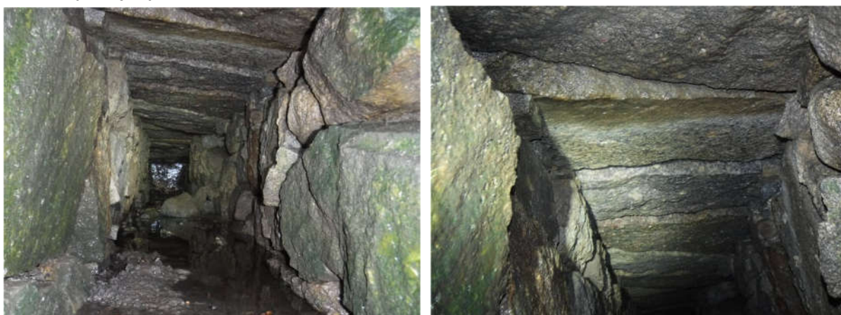
Obr. 9 Stav nosné konstrukce propustku – zatékání, jinak bez poruch
