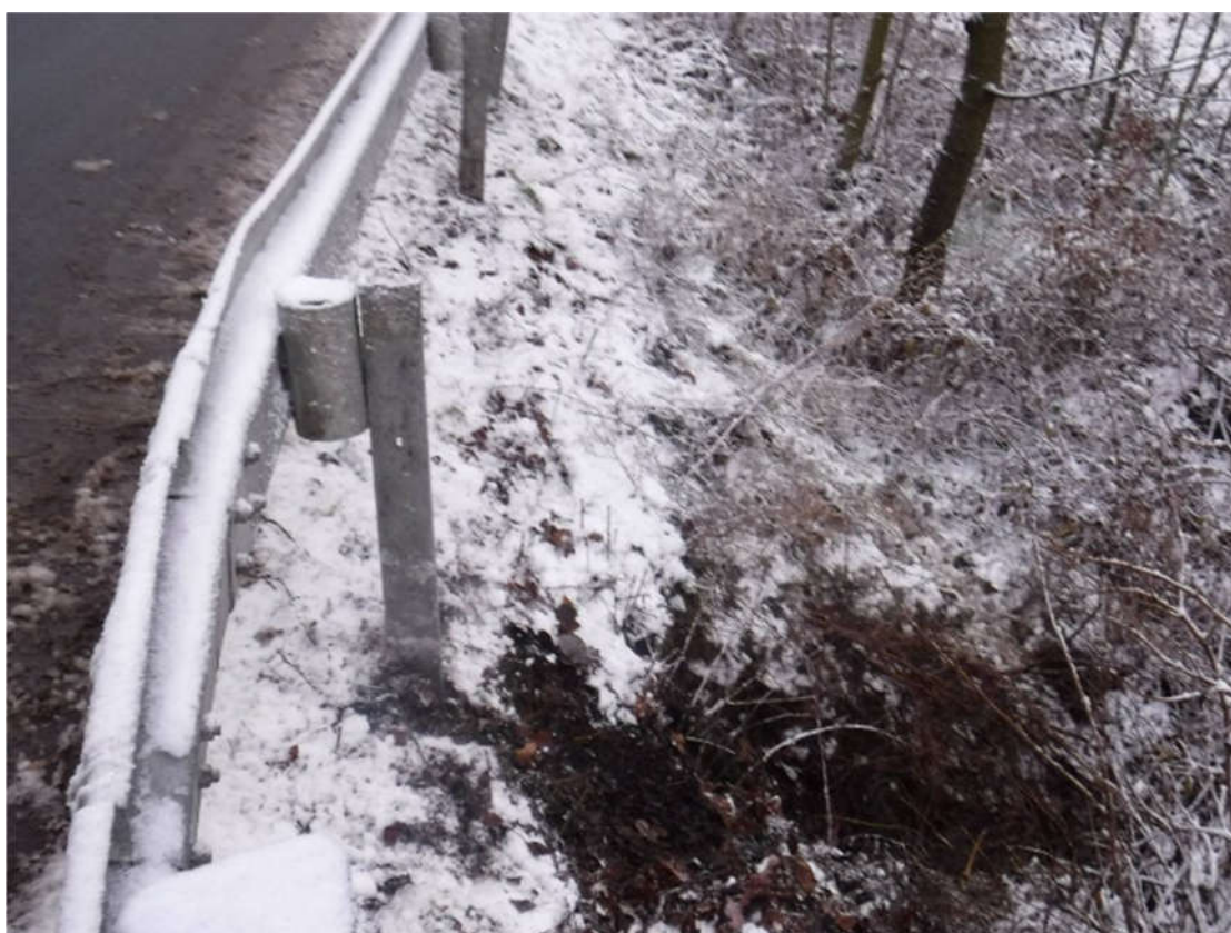
Foto 10 Konstrukce vozovky, nezpevněná krajnice – výtok
