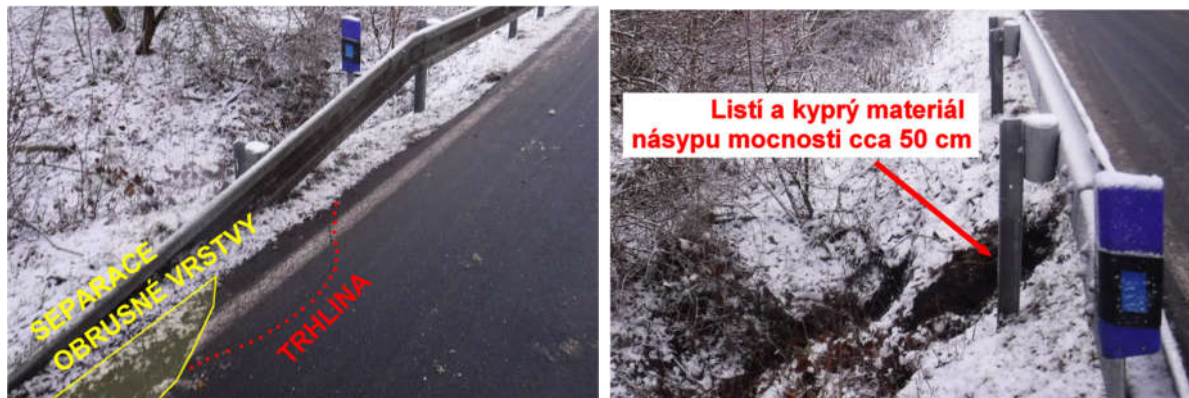
Obr. 10 Poruchy vozovky (vpravo za objektem) a násypového tělesa (na vtoku)
