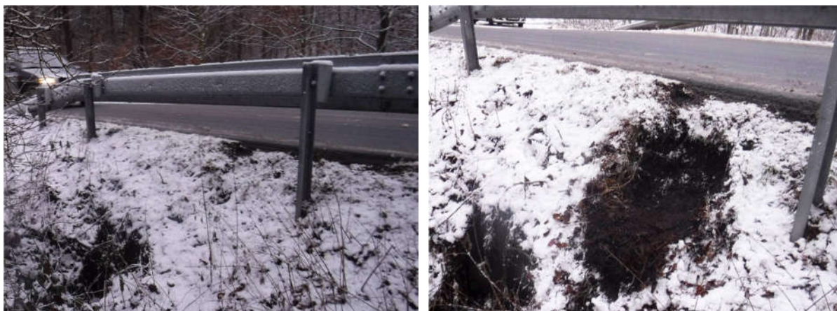
Obr. 7 Stav násypu tělesa komunikace na vtoku – nevyhovující uspořádání a hutnost materiálu
