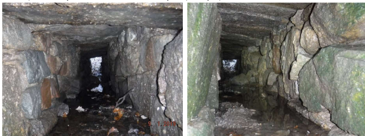
Obr. 5 Stav opěr propustku (pohled od vtoku/výtoku – vlevo/vpravo) – rozvolněné zdivo, vydrolené spárování, lokální kolaps zdiva přibližně v ose komunikace na opěře 1
