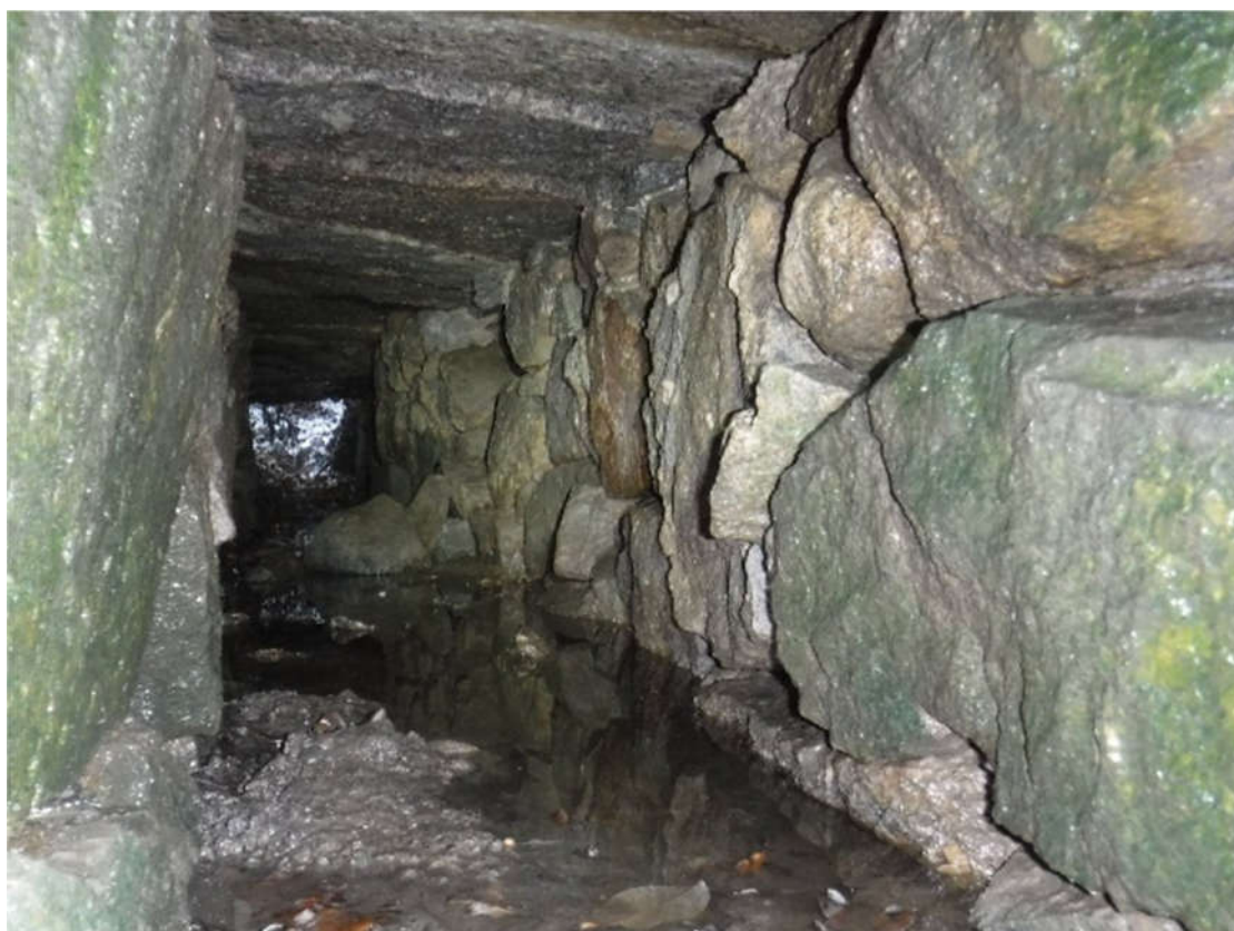
Foto 4 Stav opěr propustku – výtok
