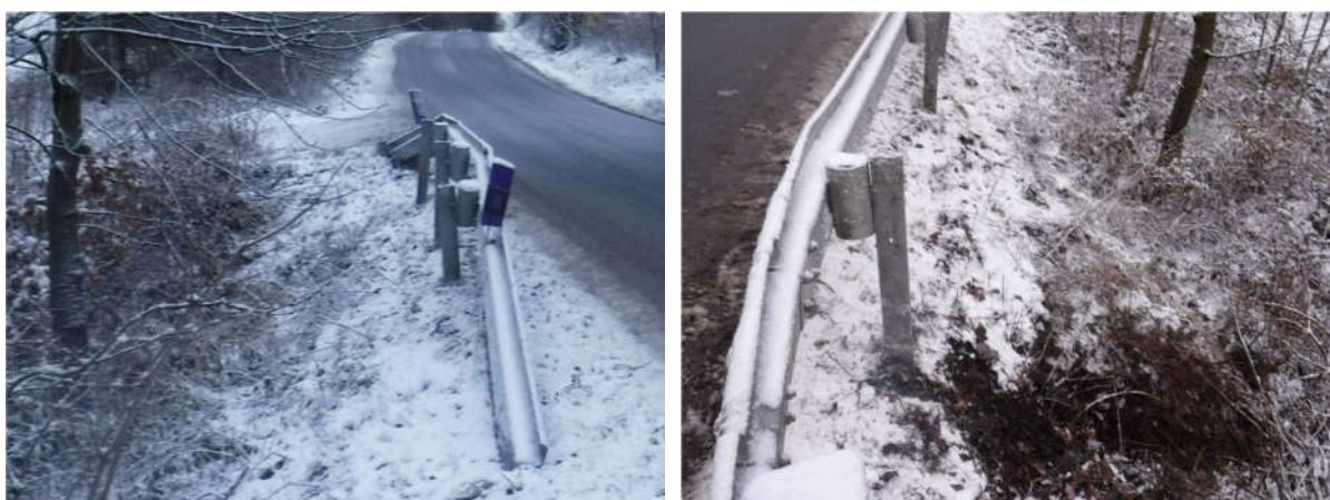
Obr. 8 Stav násypu tělesa komunikace na výtoku – nevyhovující uspořádání tělesa a hutnost materiálu
