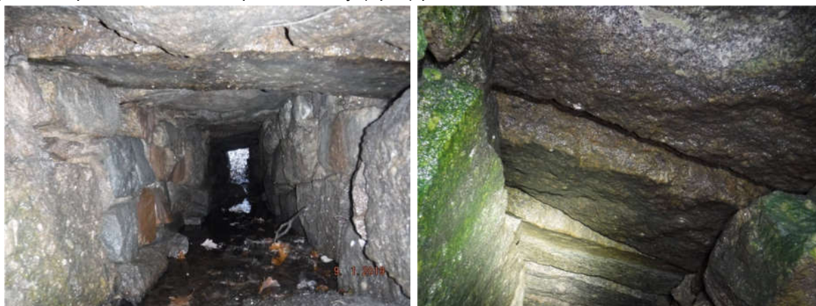
Obr. 11 Zatékání do nosné konstrukce na okrajích propustku
