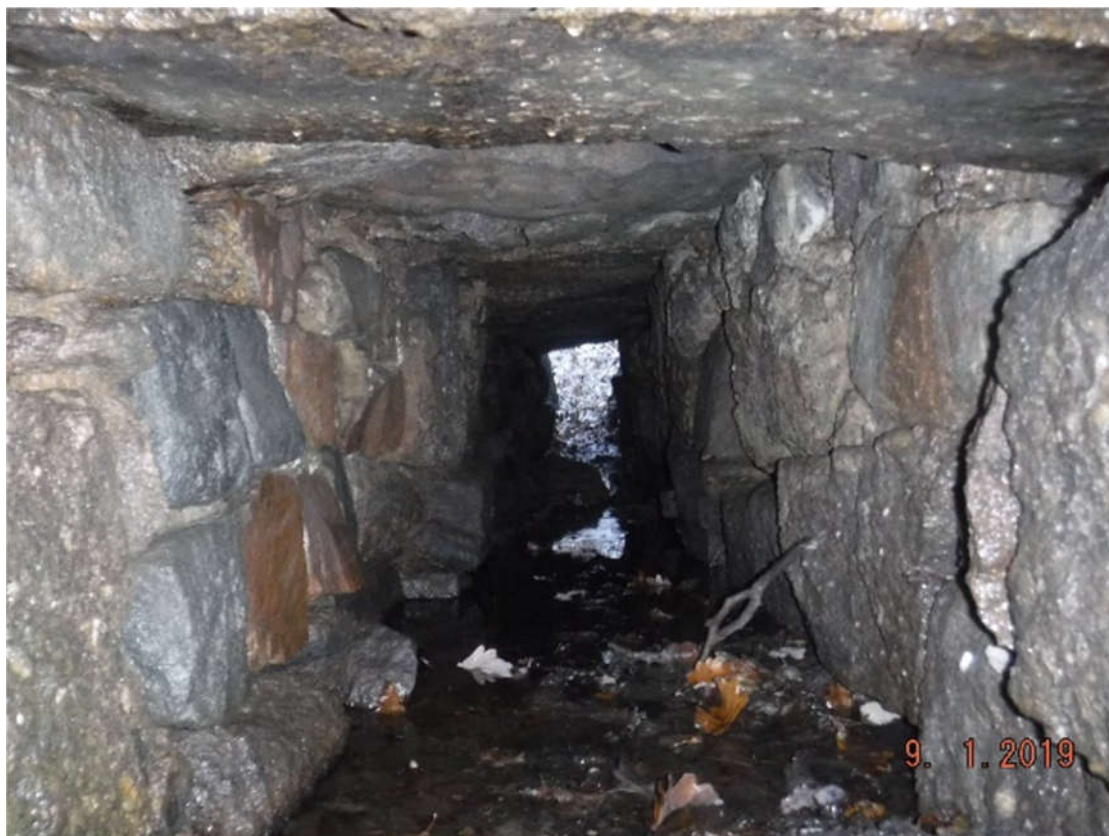
Foto 3 Stav opěr propustku – vtok
